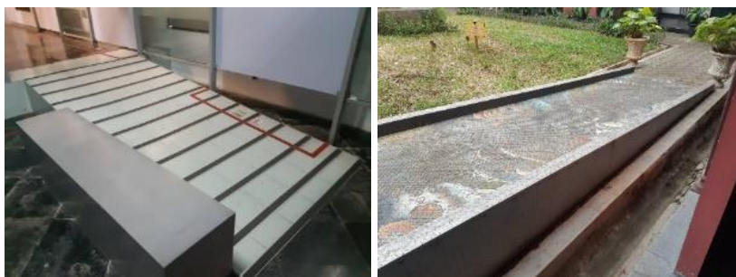
Gambar 16. Penggunaan Ramp Pada Museum
