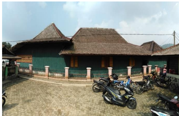
Gambar 7 Tampak Samping Rumah Gedong Gede
