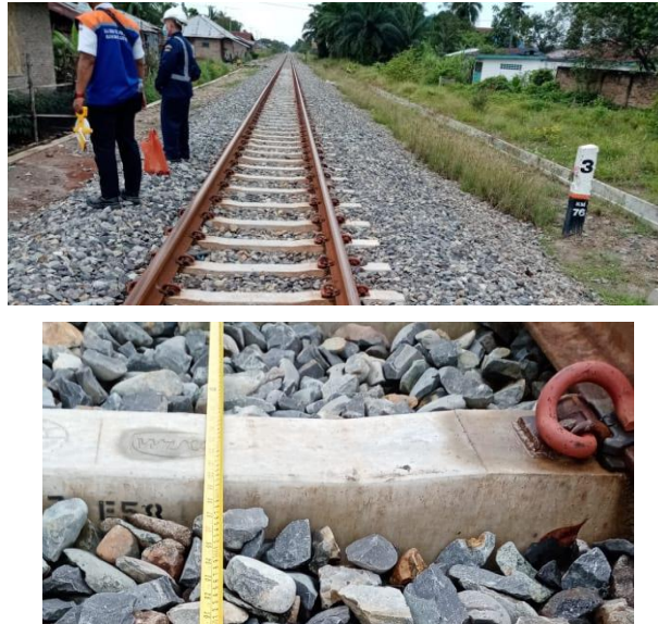
Gambar 2. Pengujian jalur kereta api
