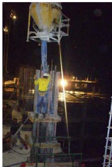
Koordinat tujuan disesuaikan dengan jenis pekerjaan yang akan dilakukan, yaitu koordinat pengecoran kolom. Dimensi kolom digunakan untuk menghitung volume dan berat campuran beton. Pada pekerjaan pengecoran, data tersebut akan digunakan untuk mengetahui berapa kali *tower crane*
