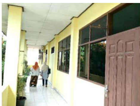
Gambar 16. Ruangan dengan Jendela yang banyak
