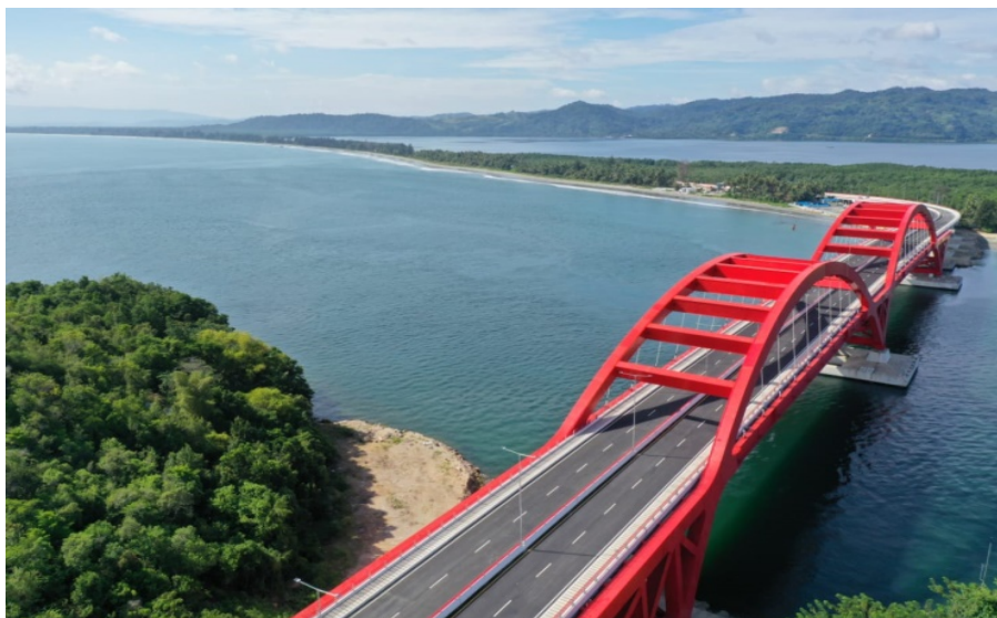
Gambar 1. Jembatan Youtefa Jayapura
