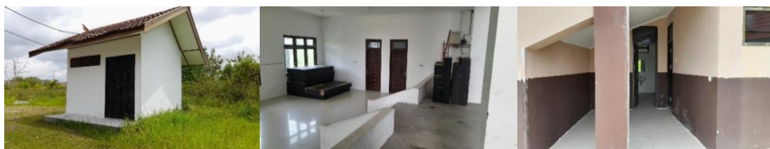
Gambar 11. Rumah Generator, Ruang Ganti, dan Toilet
