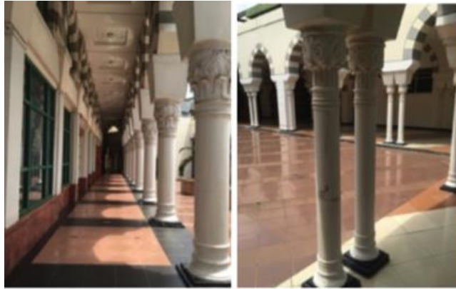
Gambar 9. Pilar-Pilar yang Mengadopsi Masjid Cordoba Di Spanyol
