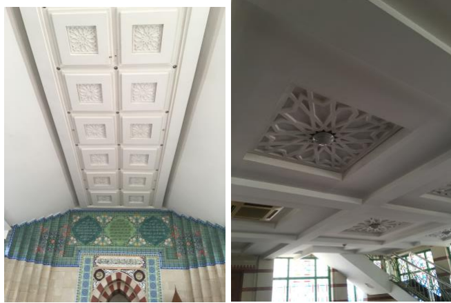
Gambar 11. Interior Bagian Atas Masjid Blok A Tanah Abang Sumber: Survei lapangan, 2020
