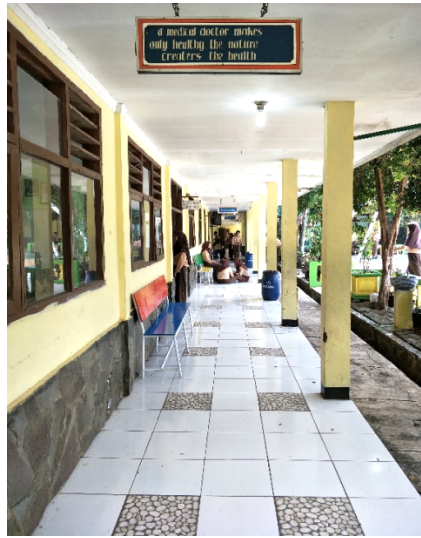
Gambar 20. Dinding Batu Alam
