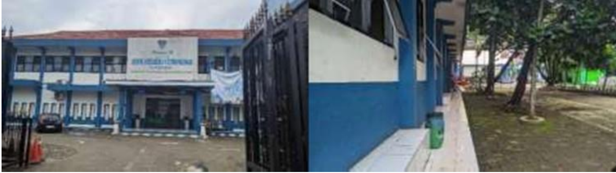
Gambar 2. Tampak Depan (kiri) dan Tampak Belakang (kanan) Gedung Teori Umum SMK Negeri 1 Cibinong
