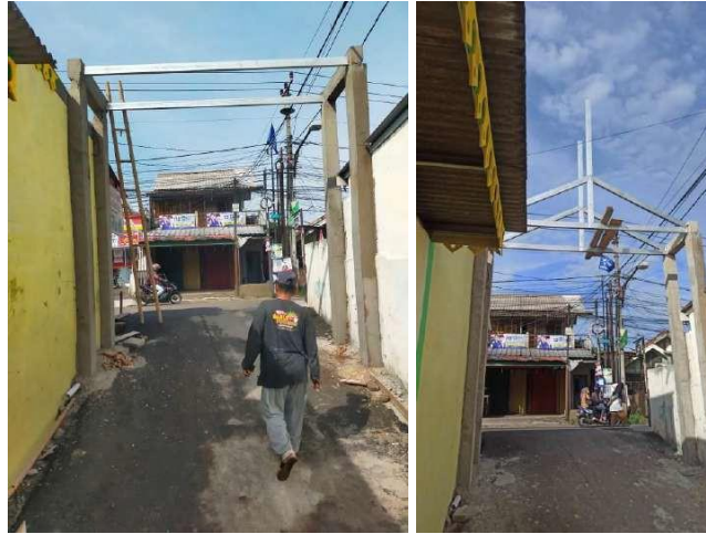
Gambar 5. Proses pembangunan Gapura di Kampung Tematik Budaya Betawi Kota Depok
