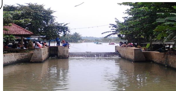
Gambar 5. Lokasi Pintu air
