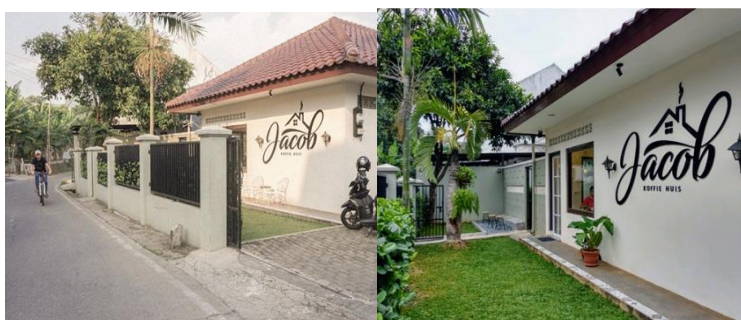
Gambar 2. Tampak Depan Bangunan
