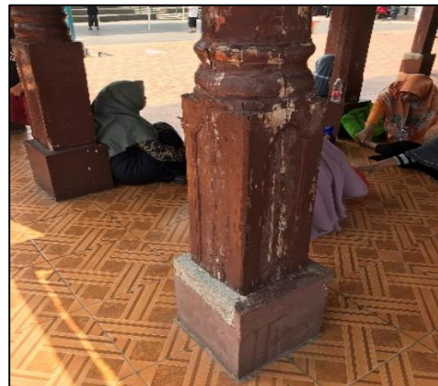
Gambar 2. Kolom Rumah Si Pitung
