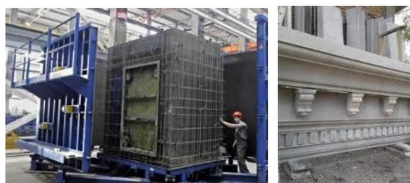
**Gambar 11. Pencetakan Material Beton (kiri) dan Penggunaan Material Beton pada Sebuah Ornamen (kanan)**
