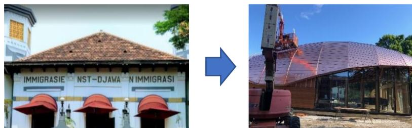
**Gambar 10. Penggunaan Material Genteng Tanah Liat pada Atap Bangunan Peninggalan Kolonial Belanda yang Dapat Dimodernisasikan dengan Material Metal Cladding**
