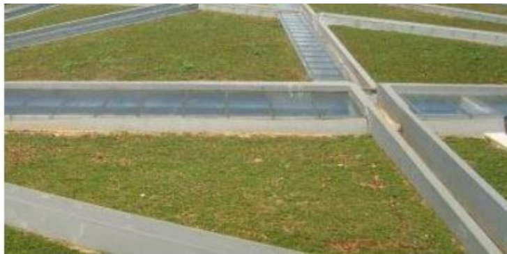
Gambar 5. Saluran air dan skylight
