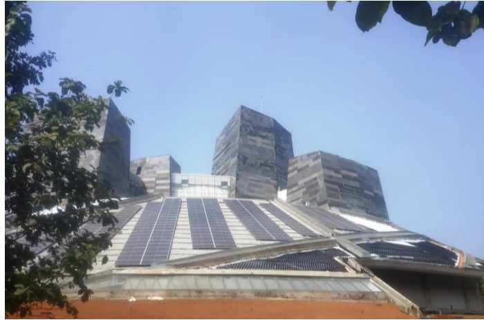
Gambar 5. Solar Panel Pada Bagian Belakang Punggung Bangunan
